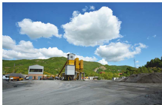
Uno dei due impianti di inerti di Grenti, quello di Ghiare di Berceto, dove l'azienda gestisce anche la trasformazione dei rifiuti da demolizione
